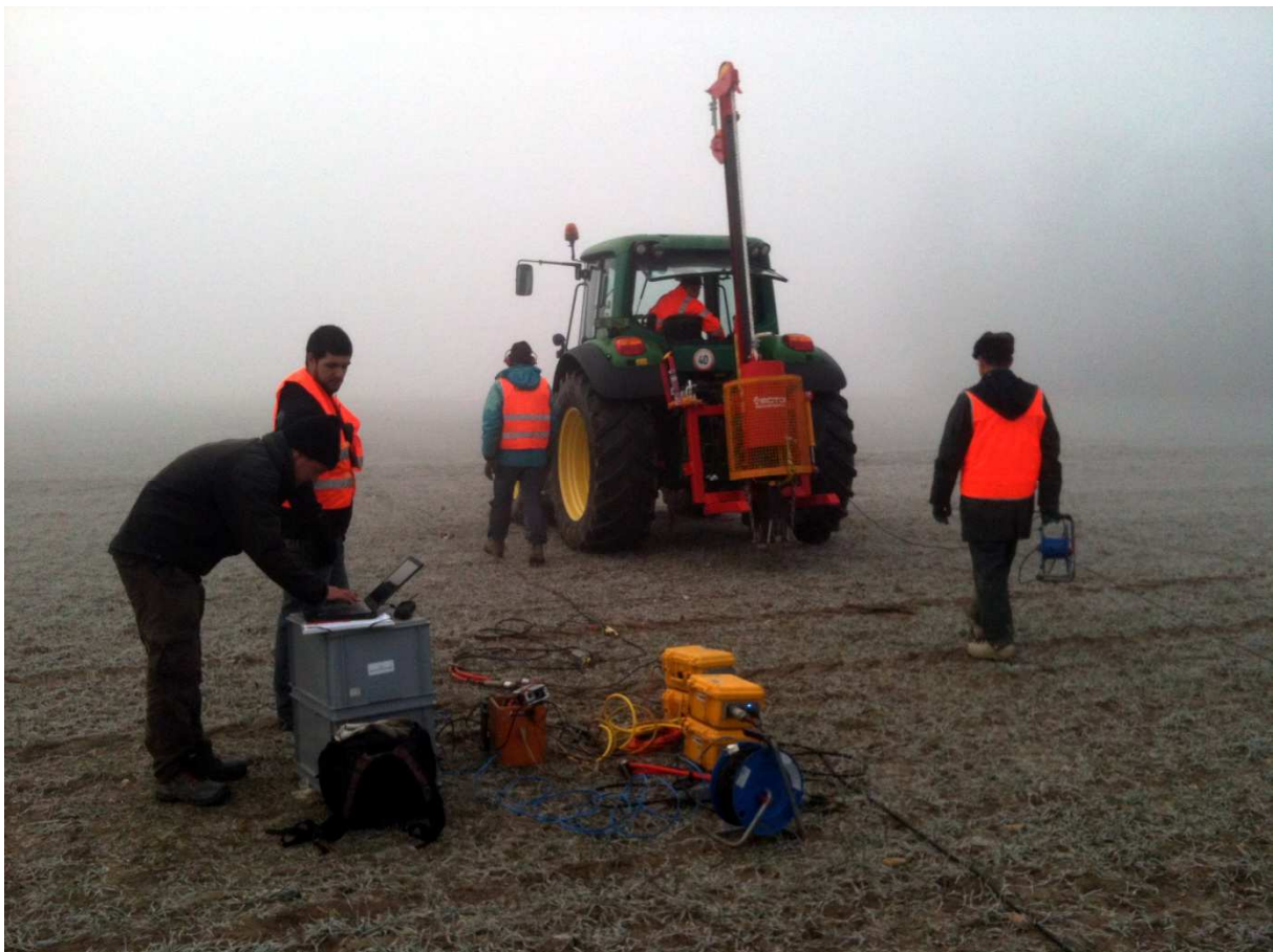
Figure 1 Source d'énergie: drop weight 400 kg
