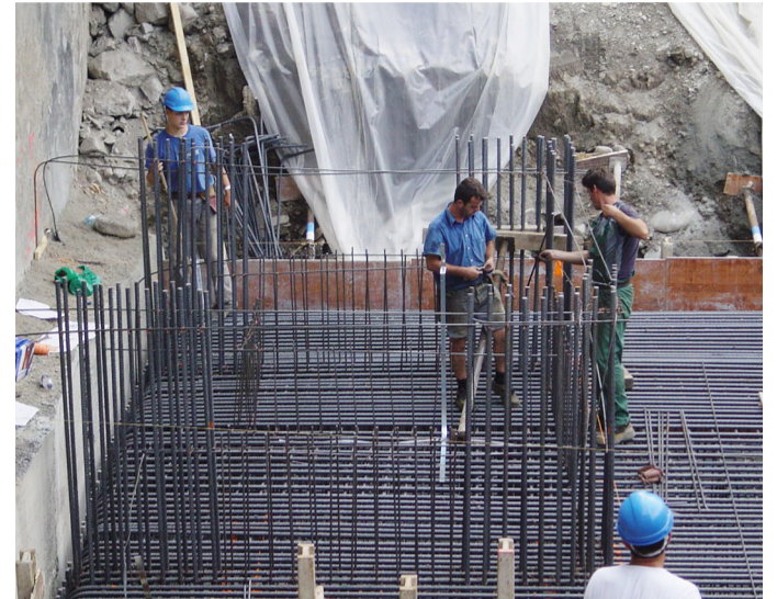
Armatures de la fondation du noyau parasismique.
