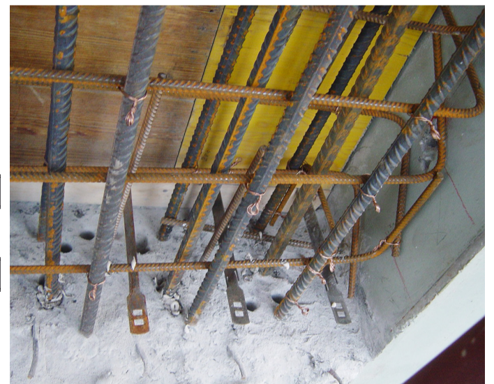
Détail de l'armature du refend parasismique.
